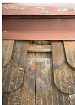
Feuchtigkeitsschäden
