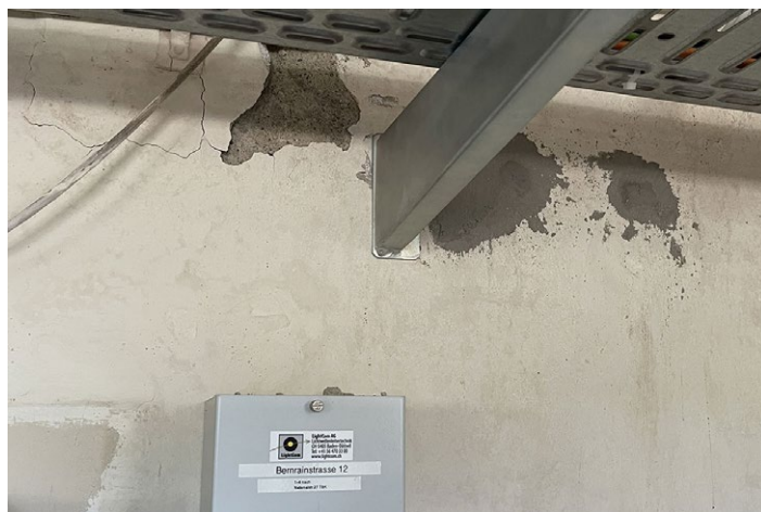
Feuchtigkeitsschäden
