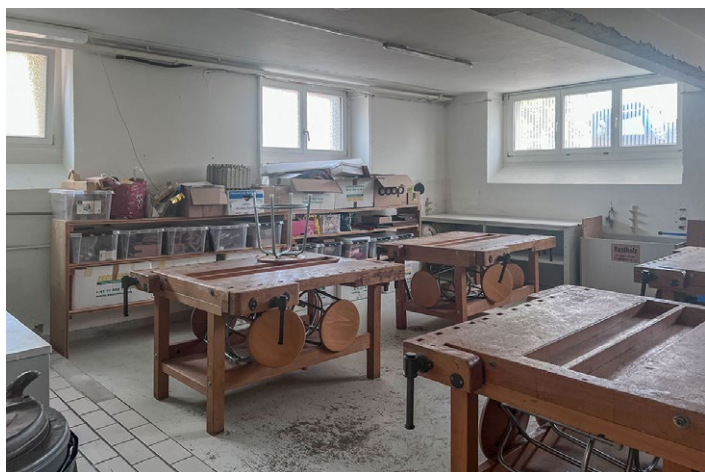
Werkraum vor der Sanierung
